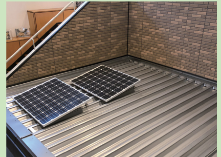
外壁や屋根などの設備をチェック
